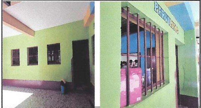
Instalación de Ventanas Pvc, pintura en muros interiores y exteriores.
