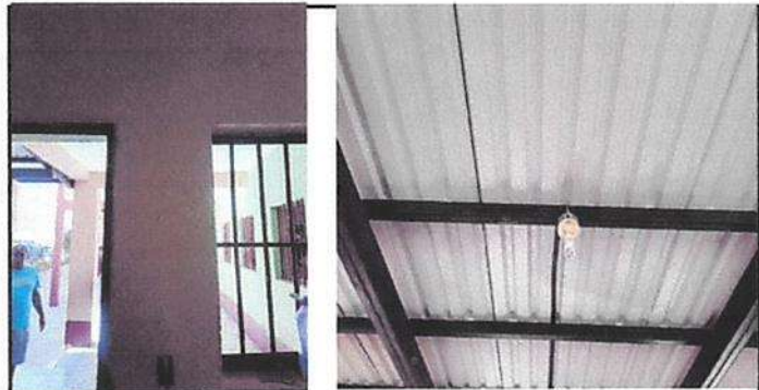
Reparación de sistema eléctrico.
