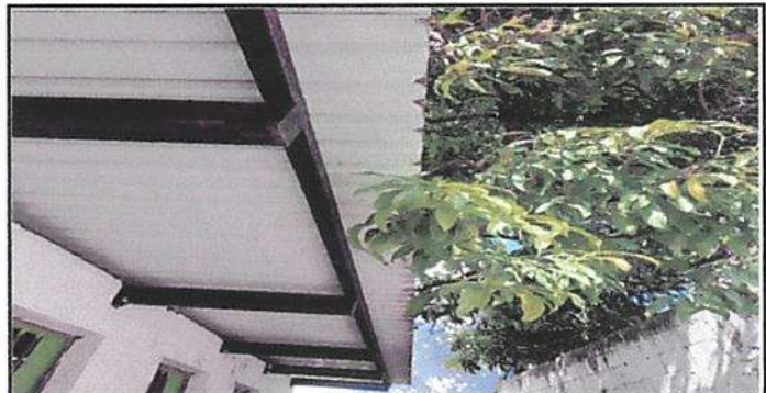
Instalación de canal de metal con sus bajada para agua pluvial.
