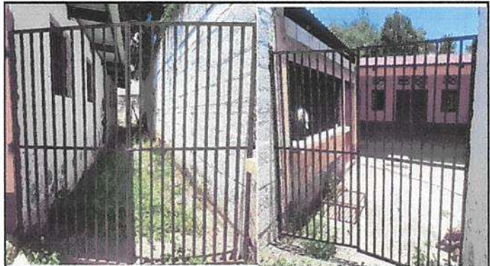
Reparación y mantenimiento a portón, instalación de puerta, va incrustada en portón.
