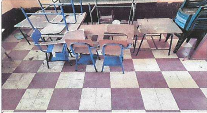
Sustitución de piso liso por piso cerámico.
