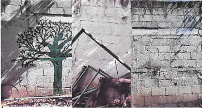
Levantado de pared para sanitarios, instalación de sanitarios, drenaje e instalación de piso cerámico antideslizante.
